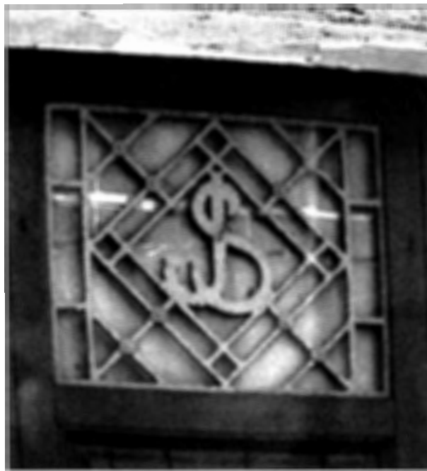
Fachada principal de "Conservas Hijos de José Serrats, S. A.". Detalle de rejería.
